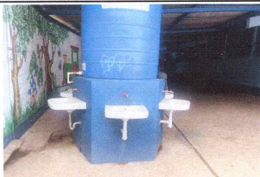
Foto 3: SERVICIOS SANITARIOS Y SUS ACCESORIOS: Sustitución lavamanos, MÓDULO 1
