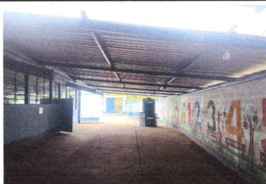
Foto 4: LOSA DE PATIO: Reparación de planchas de concreto de patio, MÓDULO 1
