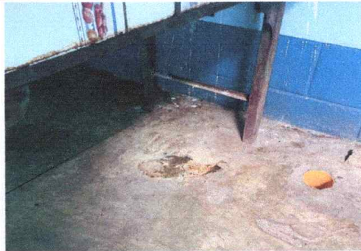
Foto 2: PISO: Sustitución de piso de torta de concreto por piso cerámico, MÓDULO 1
