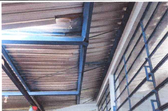
Foto 1: CUBIERTA DE LÁMINA: Sustitución de lámina, por lámina troquelada aluzinc calibre 26, MÓDULO 1
